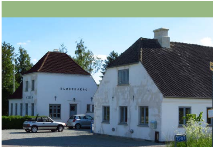
I ejendommen 'Blødebjerg' har der tidligere været smedje.
