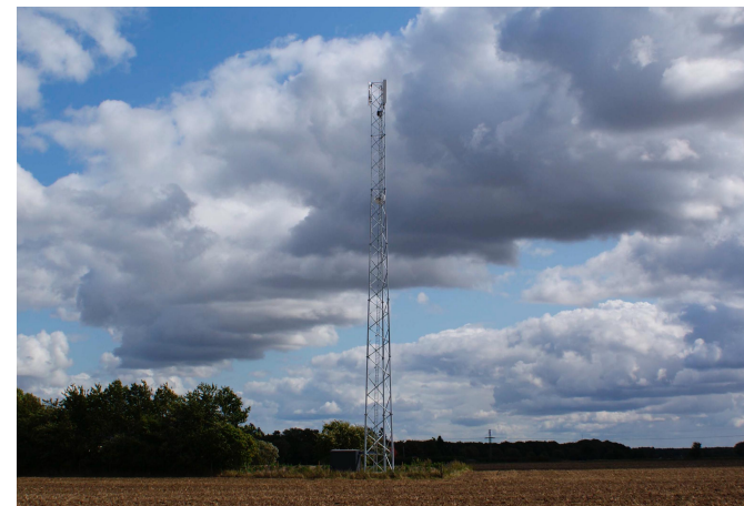
Den nye telemast ved Gyrstingevej har forbedret IT-dækningen.
