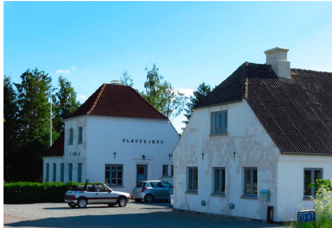
I ejendommen Blødebjerg har der været smedie. Bygningerne har bevaringsværdi.
