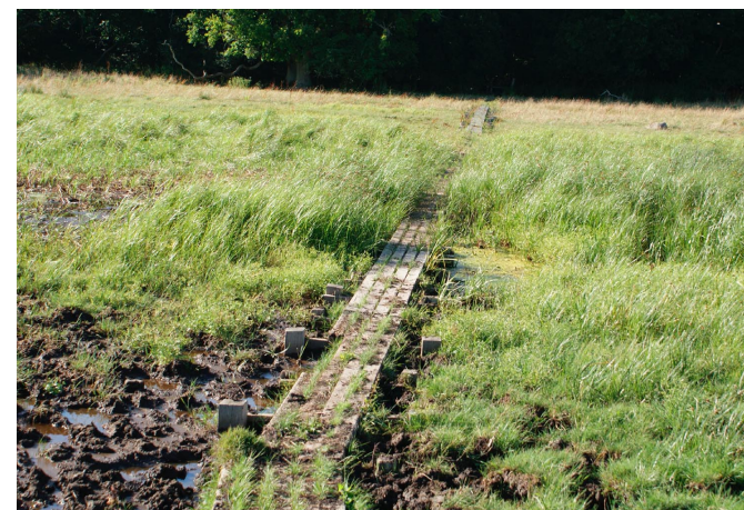
Spang eller gangbroer i træ kan sikre passage over sumpede områder. (Skovsgaard Gods, Langeland)
