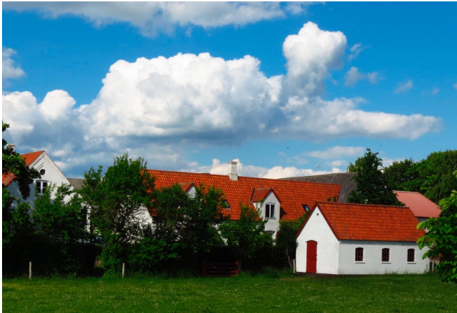
Stor Bøgeskovvej nr. 6 er udpeget som bevaringsværdig.
